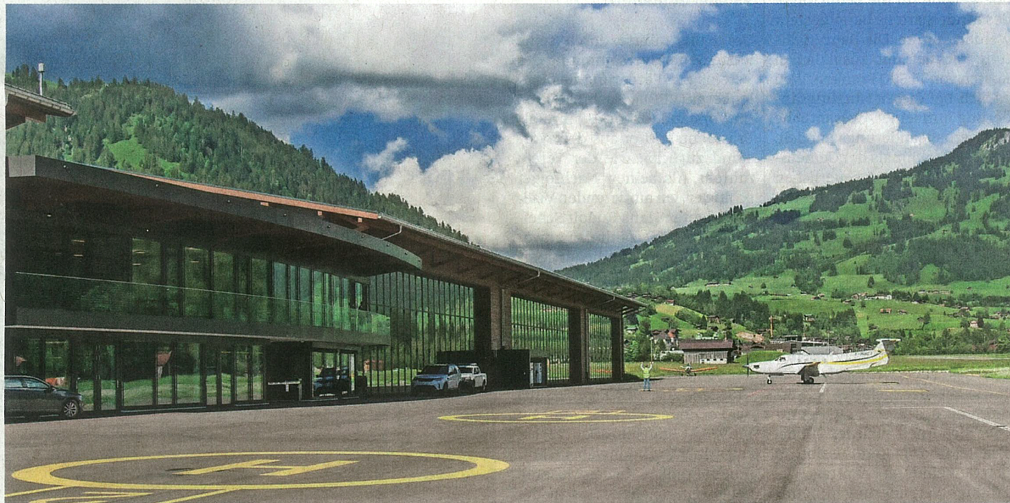
Gute Aussichten am Airport Gstaad: Der Betrieb ist im neuen Gebäude gut angelaufen. Foto: Kerem S. Maurer
